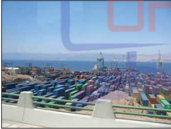
الشكل (٥-٥): صورة ميناء العقبة.
